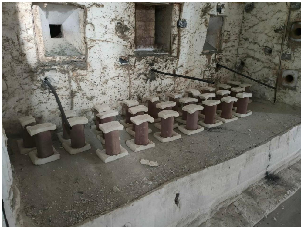
รูปที่ 47 จีโอโพลีเมอร์คอนกรีตหลังทำการทดสอบเผาไฟที่ 90 นาที
