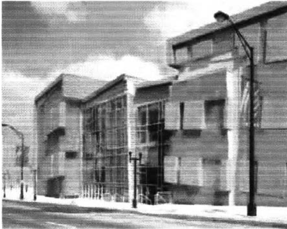
ภาพที่ 14 1994 Aronoff Building Cincinnati, OH
