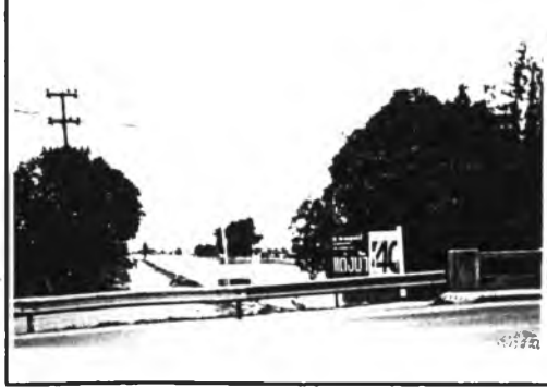
ระยะที่ 3 จากจังหวัดและบางขุน ระยะทาง 12 กม. เป็นทางด่วนยกระดับ
