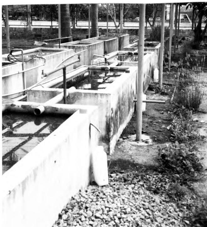
รูปที่ 3.10 แสดงการเก็บตัวอย่างน้ำที่ผ่านการบำบัดที่จุดน้ำออก
