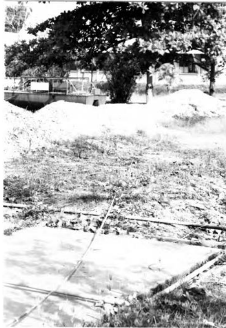
รูปที่ 3.2 แสดงการวางสายยางเพื่อสูบน้ำจากรางระบายน้ำสู่บ่อทดลอง
