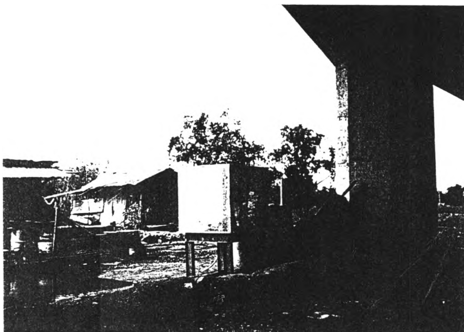
รูปที่ 10 ภาพแสดงแท่งค้ำน้ำสำหรับใช้อุปโภค-บริโภคในบ้านพัก โดยใช้ถังขนาด 1 ลบ.ม. และ ใช้บริการรถส่งน้ำของบริษัทผู้รับเหมาหลักเพื่อเติมน้ำทุกวัน (ในภาพเป็นบริเวณกลุ่ม บ้านพักแบบ "สังกะสี" บางพูน - ดค.41)
