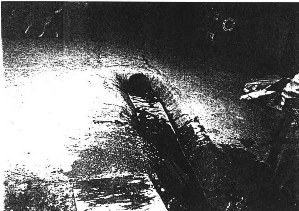
รูปที่ 22 ภาพแสดงระบบรางระบายน้ำ ซึ่งใช้ท่อระบายน้ำต่อออกนอกบริเวณบ้านพัก โดยต่อเชื่อมกับ ระบบระบายน้ำของเทศบาลริมถนนใหญ่ (ในภาพเป็นกลุ่มบ้านพัก ถ.เชียงราก - ตค 41)
