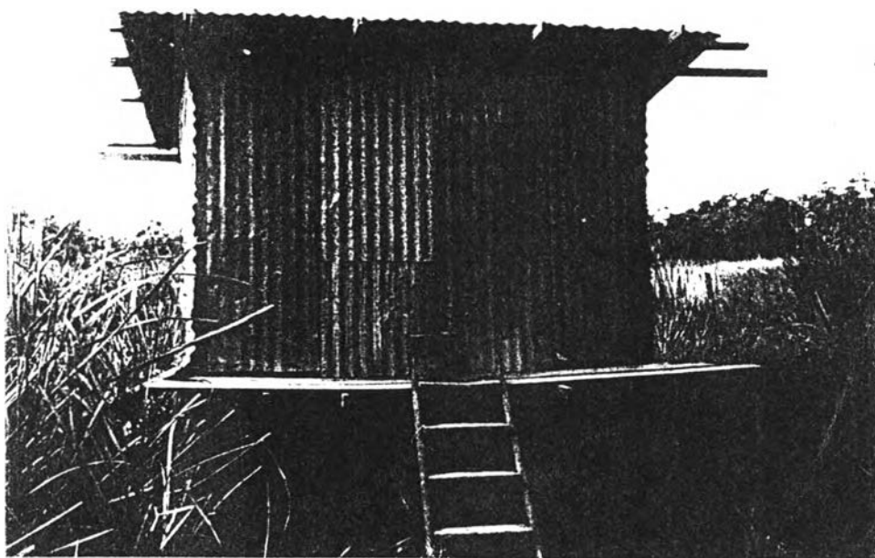
รูปที่ 16 ภาพแสดงห้องน้ำชั่วคราวที่สร้างขึ้นบนที่ลุ่มน้ำขังจึงต้องยกพื้นสูง และไม่มีไฟฟ้า แสงสว่างส่องรอบบริเวณ (ในภาพเป็นกลุ่มบ้านพักแบบ "สังกะสี" ถ.ศรีสมาน-ตค.41)
