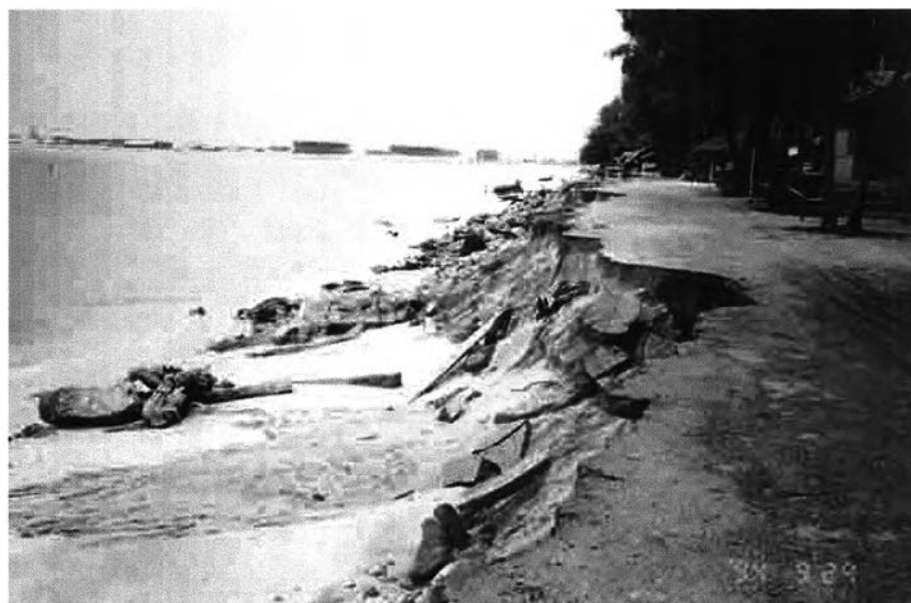
รูป 4.33 การกัดเซาะของชายฝั่งบริเวณหาดตากวนทางด้านตะวันออกของนิคมอุตสาหกรรมมาบตาพุด หลังจากมีการถมทะเลระยะที่ 1
