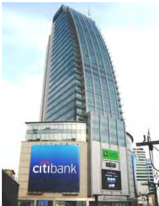
รูปที่ 8 อาคารอินเตอร์เซนจ์ 21
