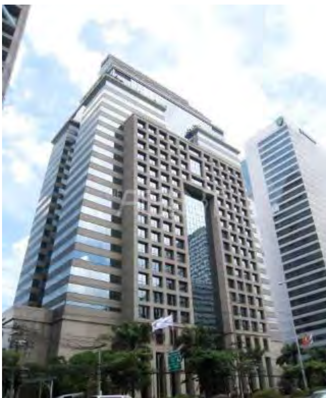
รูปที่ 5 อาคารสาทรซีดี ทาวเวอร์
