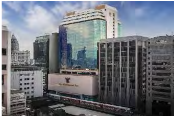
รูปที่ 10 อาคารซี.พี. ทาวเวอร์ (สีลม)
