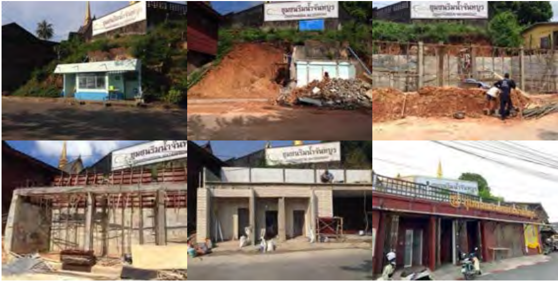
ภาพที่ 35 รูปขณะก่อสร้างศูนย์บริการนักท่องเที่ยวบริเวณหัวถนนสุขาภิบาล ที่ ๓ : เทศบาลเมืองจันทบุรี, 2560
