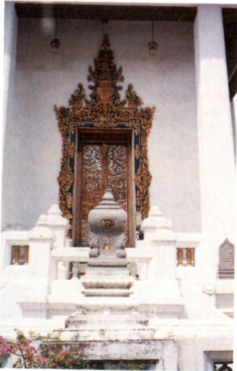
ซุ้มประตูประอุโบสถ เป็นปูนปั้นปิดทองเป็นรูปมงกุฎวางบนพาน โดยรอบประดิษฐ์ลวดลายดอกบัว
