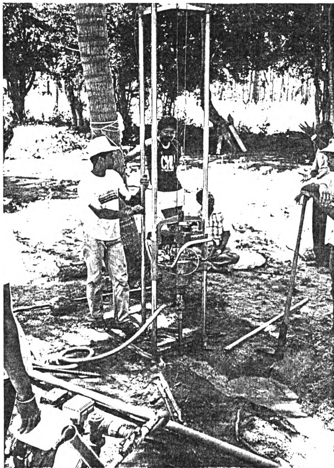
1. เครื่องมือเจาะบ่อน้ำตึก 2. ลักษณะหัวเจาะ 3. ลักษณะท่อกรอง 4. การขยายปลายท่อ 5. การเชื่อมต่อ 2 ท่อน รูปที่ 4.25 การขุดเจาะบ่อน้ำตึกและการนำน้ำมาใช้
