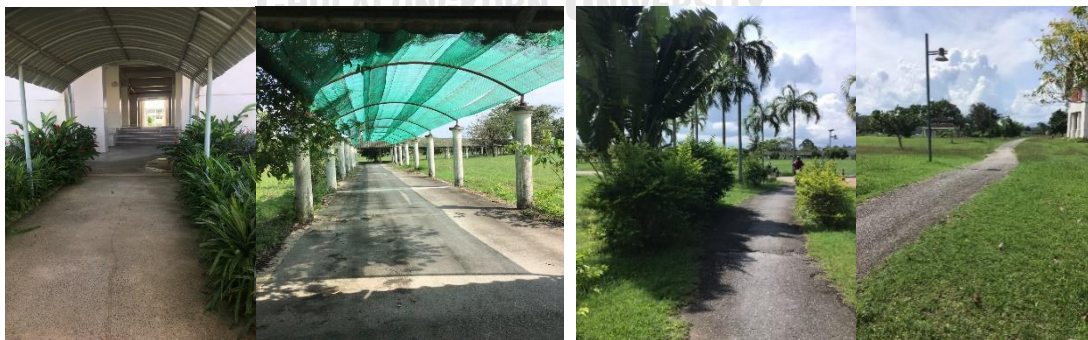
ภาพที่ 4.24 แสดงรูปแบบทางเท้ามีหลังคาคลุมและทางจักรยานพื้นผิวคอนกรีตของมหาวิทยาลัยวลัยลักษณ์ ที่มา : จากการสำรวจ 2560 – 2561
