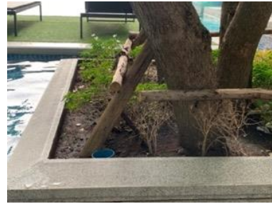
พุดศุภโชค ที่อยู่บริเวณกระบะปลูก ริมสระว่ายน้ำ มีสภาพยืนต้นตาย
