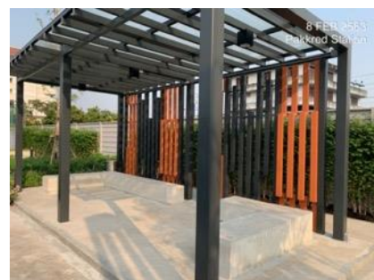
ศาลาพักผ่อนภายในสวนสำหรับเป็นพื้นที่พักผ่อน ทำ จากโครงสร้างเหล็กและคอนกรีต
