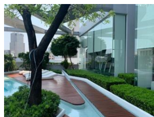
วัสดุ hardscape ของสระว่ายน้ำเป็นโครงสร้างคอนกรีตปูด้วย กระเบื้องหินแกรนิต
