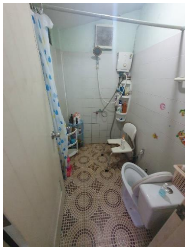
ภาพที่ 109 พื้นที่ห้องน้ำ กรณีศึกษาหลังที่ 25 ห้องน้ำมีโถส้วมแบบนั่งราบ มีพนักพิง มีเก้าอี้อาบน้ำ มีม่านอาบน้ำ แต่ยังไม่มีการจับช่วยพยุง ตัวข้างโถส้วม
