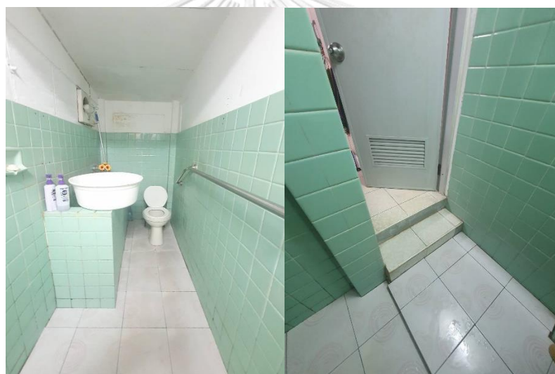
ภาพที่ 103 พื้นที่ห้องน้ำกรณีศึกษาหลังที่ 22 พื้นห้องน้ำลดระดับลง 25 ซม. โถส้วมเป็นแบบนั่งราบแต่ไม่มีที่พิงหลัง มีราวจับสูงจากพื้น 1 เมตร
