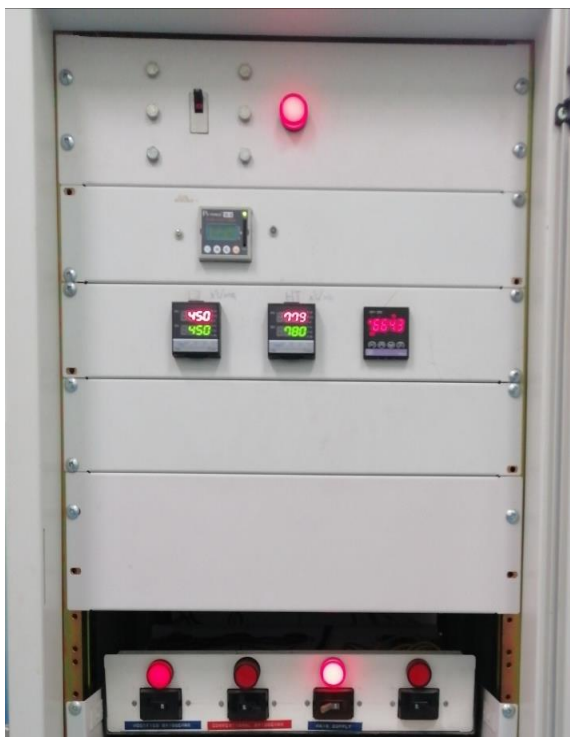
ภาพที่ 3.7 ระบบควบคุมและบันทึกอุณหภูมิ
