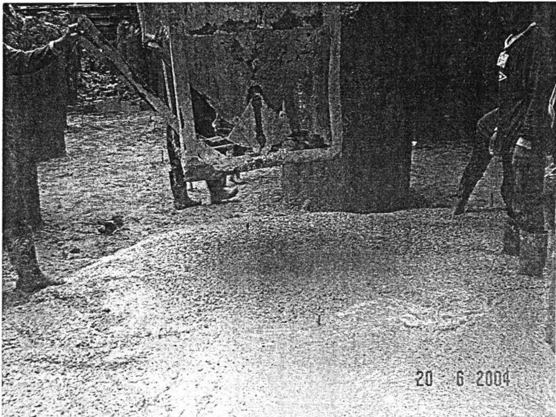
รูปที่ 3.14 แสดงการเทคอนกรีตหยาบ (Lean Concrete)
