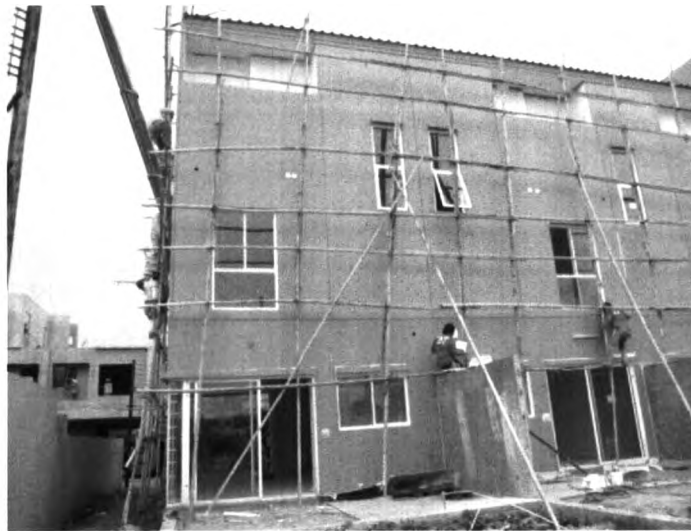
รูปที่ 4.8 คนทำงานใส่เสื้อตามสีและลำดับงานย่อยที่กำหนดในระหว่างก่อสร้าง
