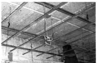
ภาพแสดงการติดตั้งโครงคร่าว
