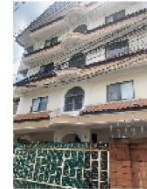
ตึกแถวที่ใช้พักอาศัยเท่านั้น
