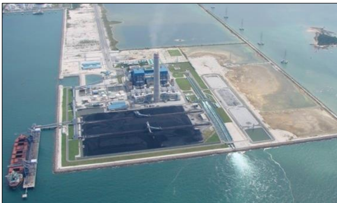
รูปที่ 1.5-1 โรงไฟฟ้าบีแอลซีพี
