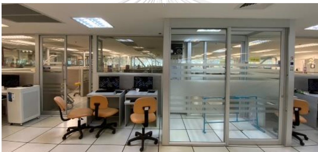
รูปที่ 62 ฉากกันคลินิกห้องรวม ( open plan ) ด้วยผนังกระจกเป็นห้องความดันลบ
