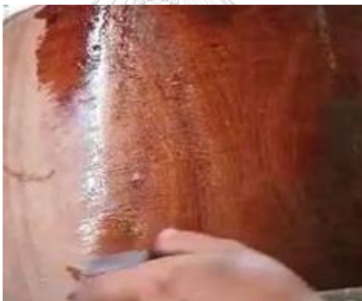
ภาพที่ 74 การทาน้ำยากันมอด
