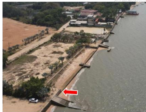
กำแพงกันคลื่น (seawall)
