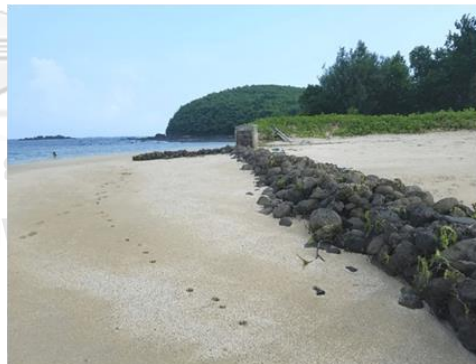
เขื่อนกันทรายและคลื่น (jetty) (Mörner and Matlack-Klein, 2017)
