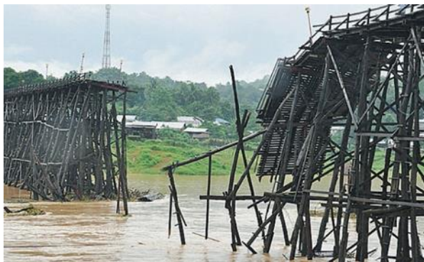
ภาพที่ 13 ภาพสะพานอุตตมานุสรณ์ถูกน้ำป่าพัดจนสะพานพังในวันที่ 28 กรกฎาคม 2556 ที่มา: http://rlocal.kru.ac.th/index.php/th สืบค้นเมื่อวันที่ 2 มีนาคม 2565
