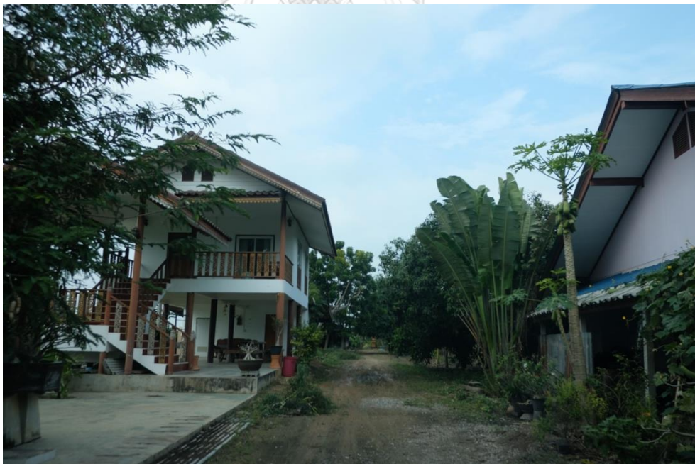
ภาพที่ 45 ทางเข้าด้านหน้าโรงงาน ที่มา: ศลิตรา ธรรมรัตน์
