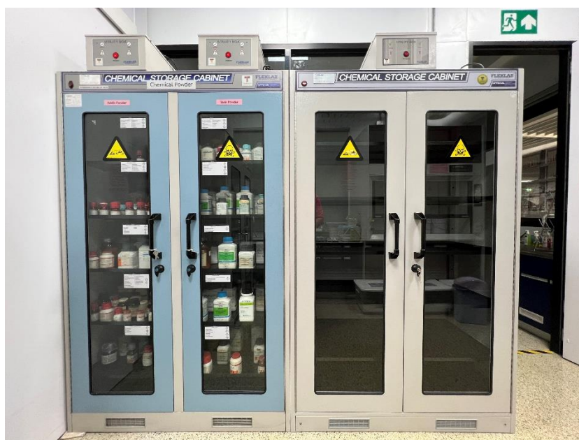
ภาพที่ 4-20 (ซ้าย) การจัดประเภทสารเคมีและติดรายการสารเคมีและสัญลักษณ์ความเป็นอันตรายตามระบบ GHS (ขวา) ตู้เก็บสารเคมีสำหรับสารออกซิไดส์ที่ภาควิชาเคมีคลินิกได้รับการจัดสรรงบประมาณการจัดซื้อเมื่อปีงบประมาณ 2565
