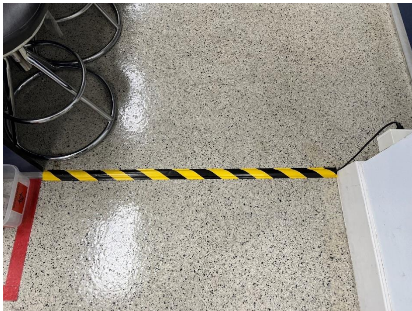
ภาพที่ 4-29 การจัดเก็บสายไฟและสาย HDMI สำหรับเชื่อมต่อโสตทัศนูปกรณ์ภายในห้องปฏิบัติการเคมีคลินิก
