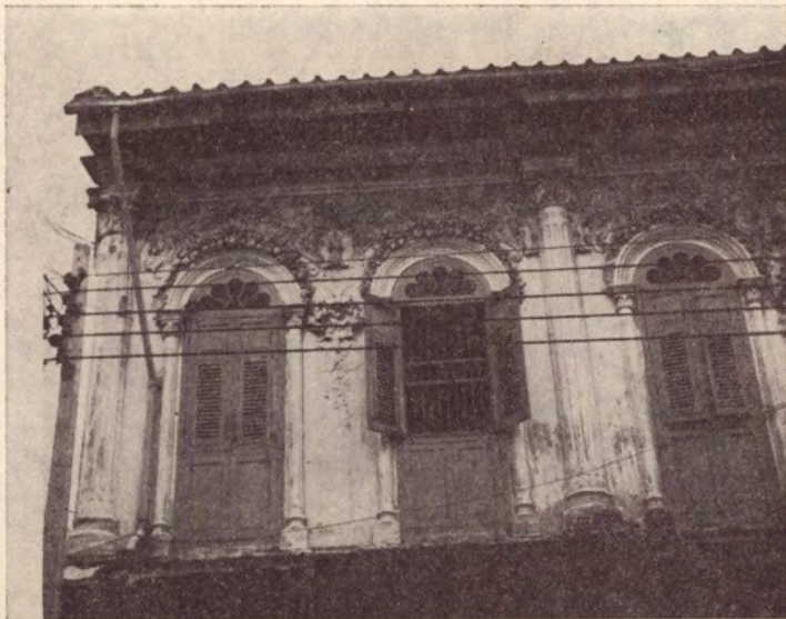
รูป 10 อาคารตรงถนนทรงวาด
