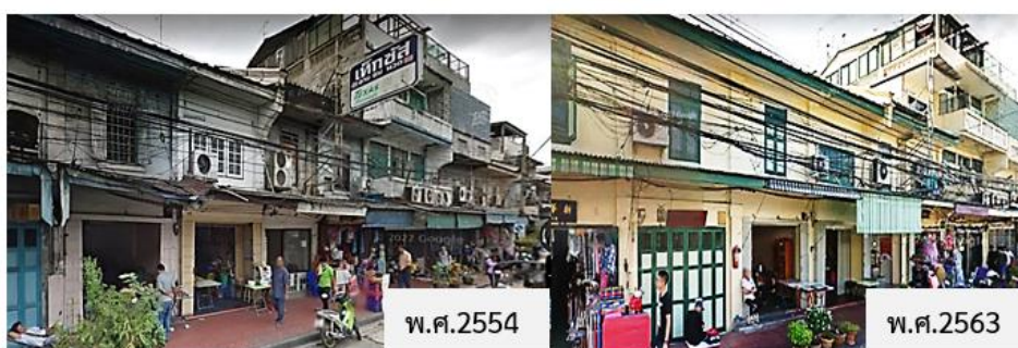
ภาพที่ 35 การซ่อมแซมอาคารริมถนนทรงสวัสดิ์ ที่มา Google street view พ.ศ. 2554 – 2563
