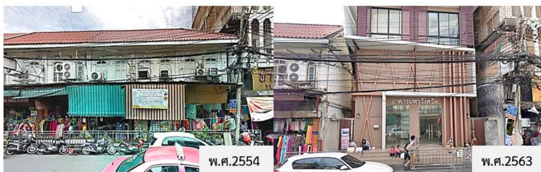
ภาพที่ 42 การรื้อถอนอาคารพาณิชย์ในสมัยรัชกาลที่ 5 เพื่อสร้างอาคารสมัยใหม่ ที่มา Google Streetview พ.ศ. 2554 – 2563
