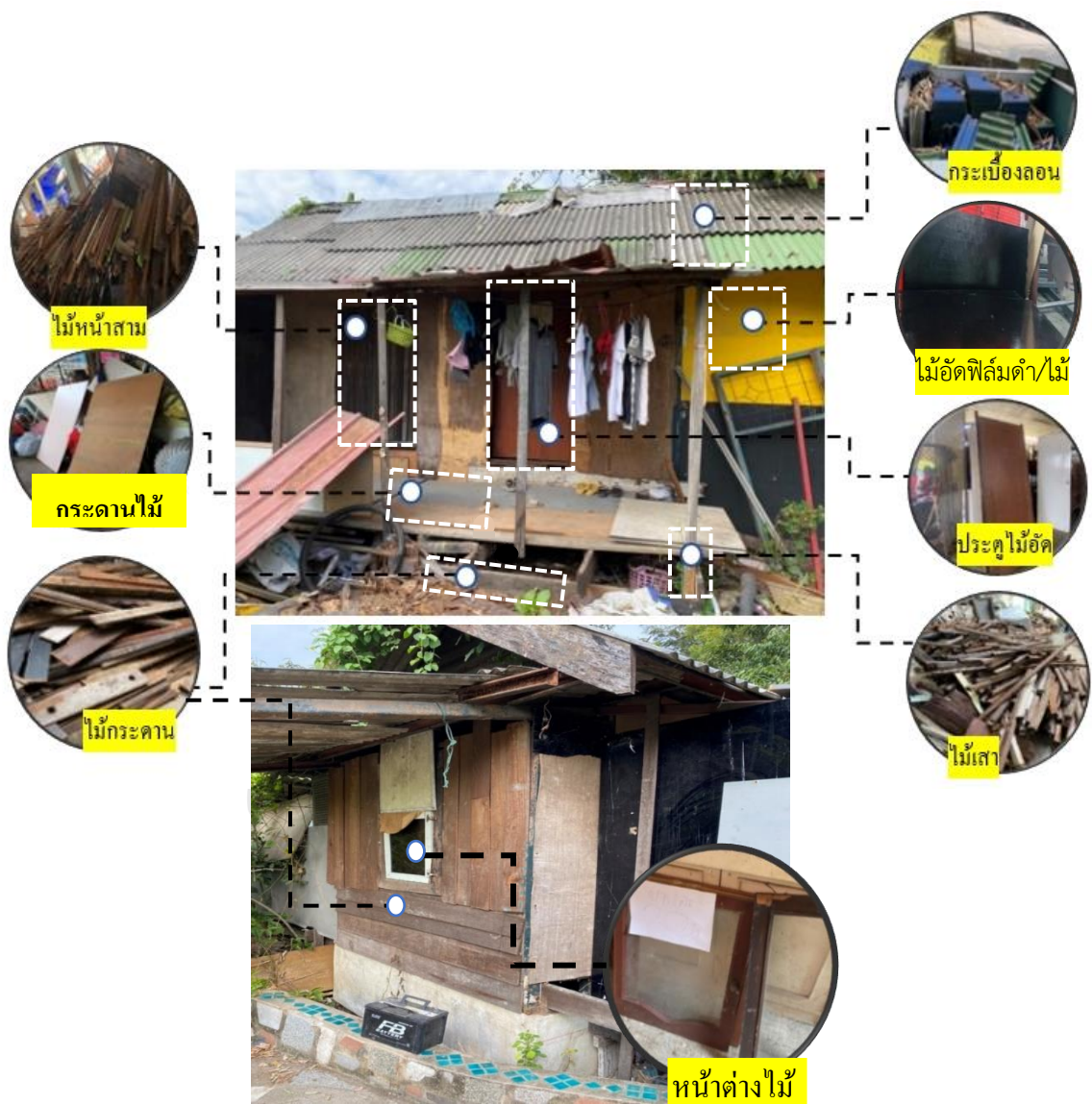
ภาพที่ 5-8 แสดงองค์ประกอบการใช้วัสดุก่อสร้างมือสองของบ้านหลังที่ 2
