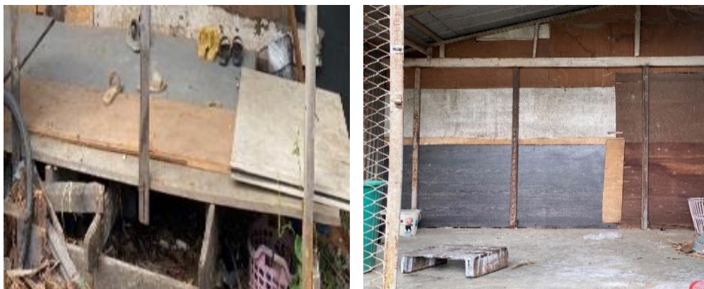
ภาพที่ 6-1 แสดงลักษณะของปัญหาวัสดุชำรุดเสียหาย และถูกแก้ไขด้วยการเปลี่ยนวัสดุใหม่
