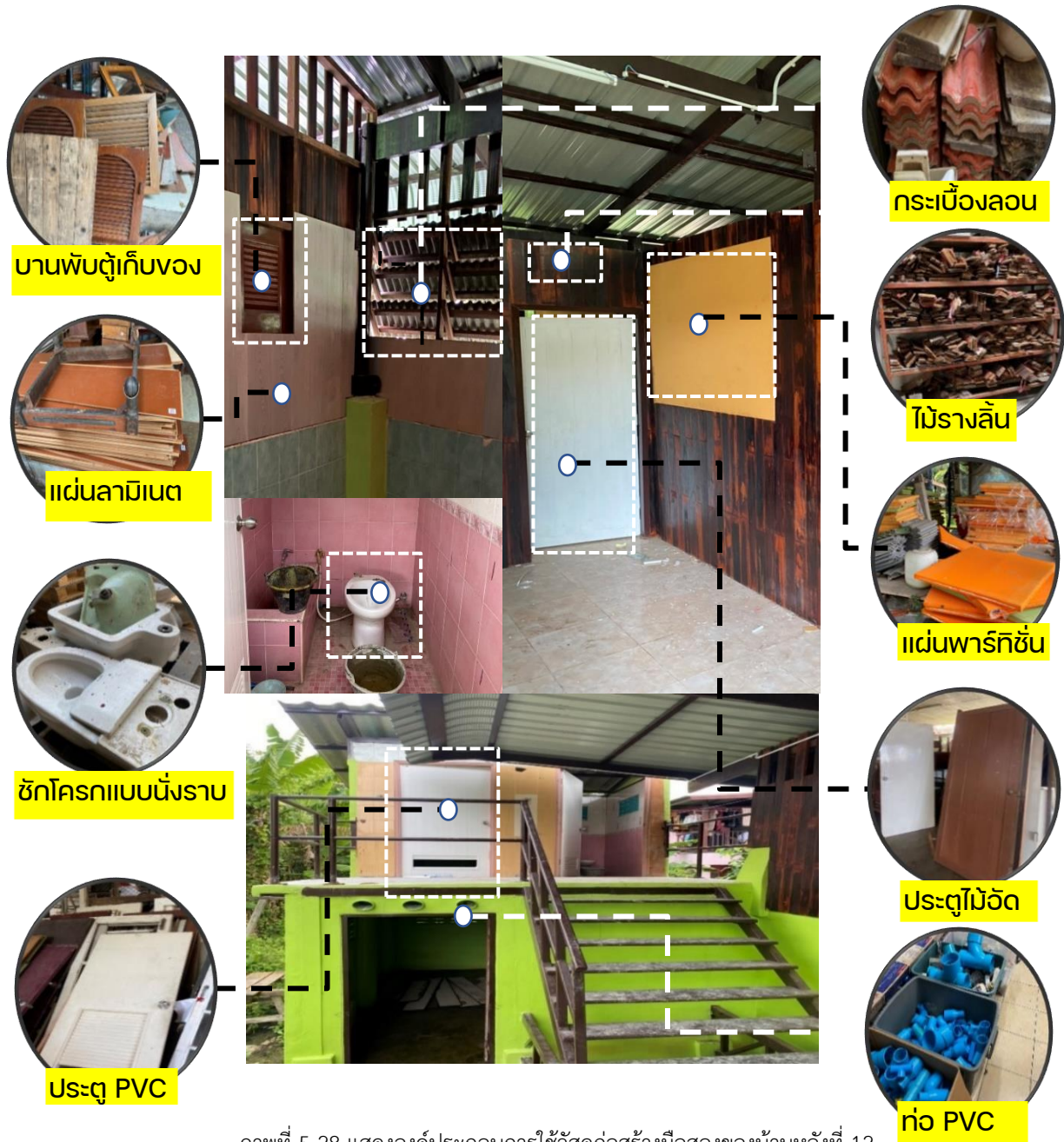
ภาพที่ 5-28 แสดงองค์ประกอบการใช้วัสดุก่อสร้างมือสองของบ้านหลังที่ 12
