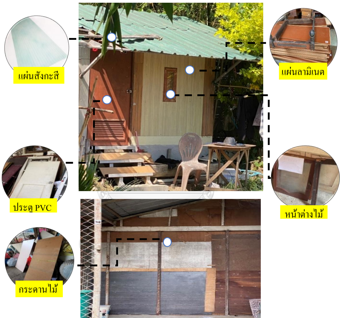
ภาพที่ 5-10 แสดงองค์ประกอบการใช้วัสดุก่อสร้างมือสองของบ้านหลังที่ 3
