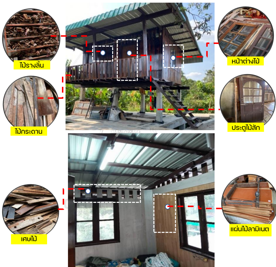
ภาพที่ 5-18 แสดงองค์ประกอบการใช้วัสดุก่อสร้างมือสองของบ้านหลังที่ 7
