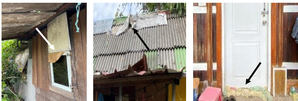
ภาพที่ 6-2 แสดงลักษณะของปัญหาน้ำรั่วเข้าภายในบ้าน และถูกแก้ไขปัญหาในเบื้องต้น
