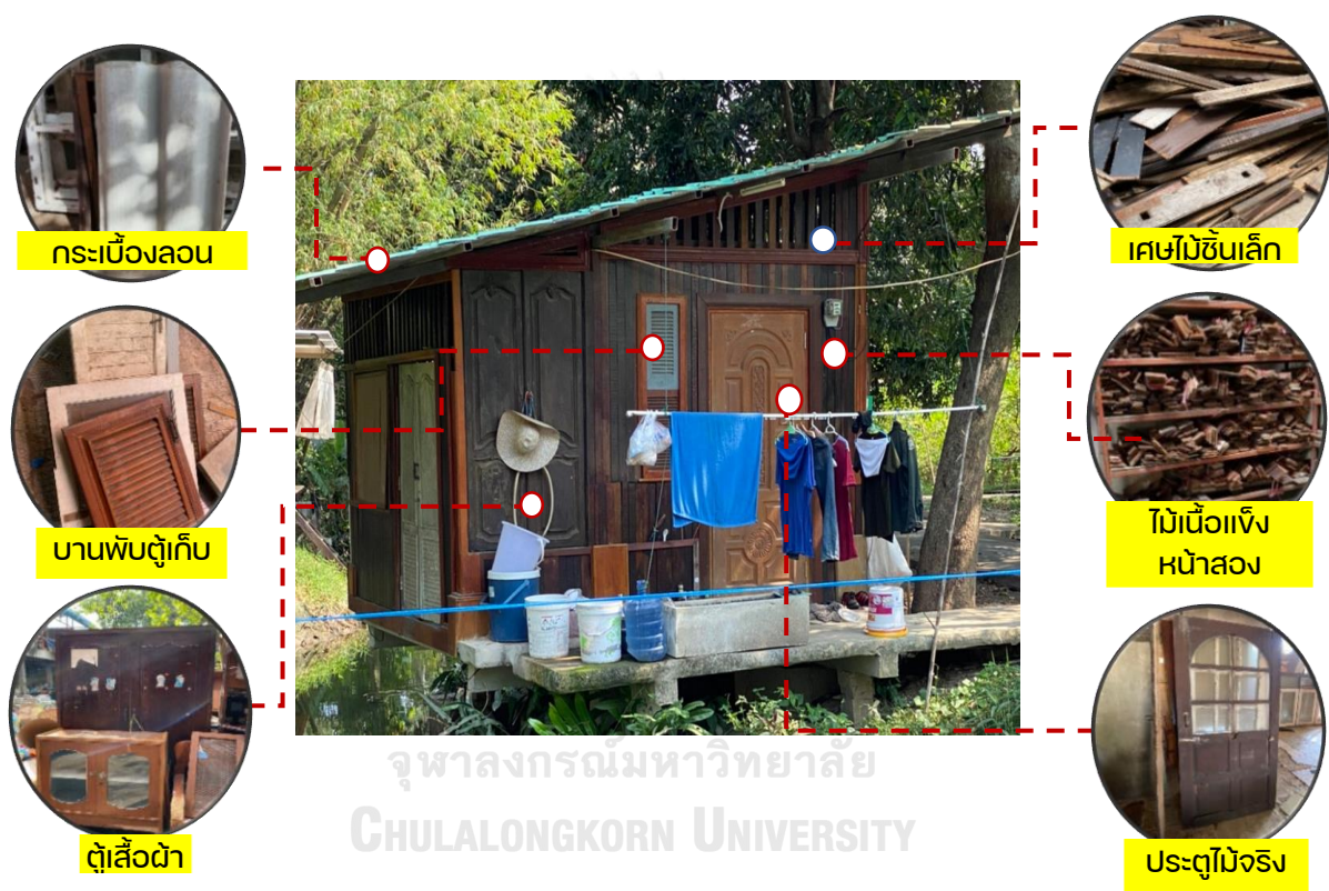
ภาพที่ 5-14 แสดงองค์ประกอบการใช้วัสดุก่อสร้างมือสองของบ้านหลังที่ 5
