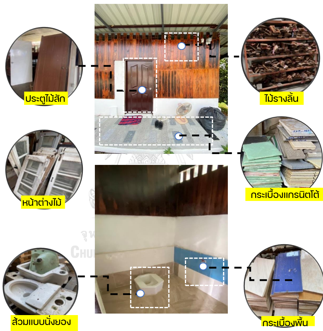
ภาพที่ 5-26 แสดงองค์ประกอบการใช้วัสดุก่อสร้างมือสองของบ้านหลังที่ 11
