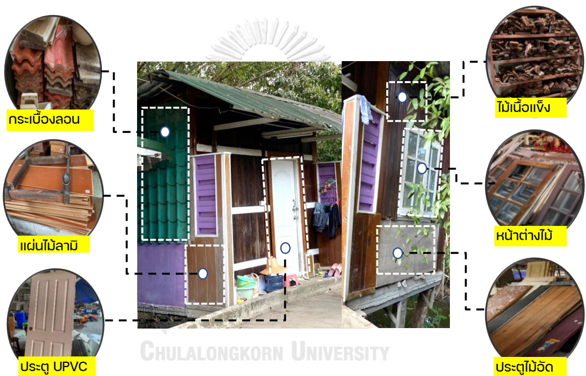
ภาพที่ 5-12 แสดงองค์ประกอบการใช้วัสดุก่อสร้างมือสองของบ้านหลังที่ 4
