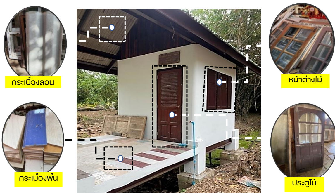
ภาพที่ 5-20 แสดงองค์ประกอบการใช้วัสดุก่อสร้างมือสองของบ้านหลังที่ 8
