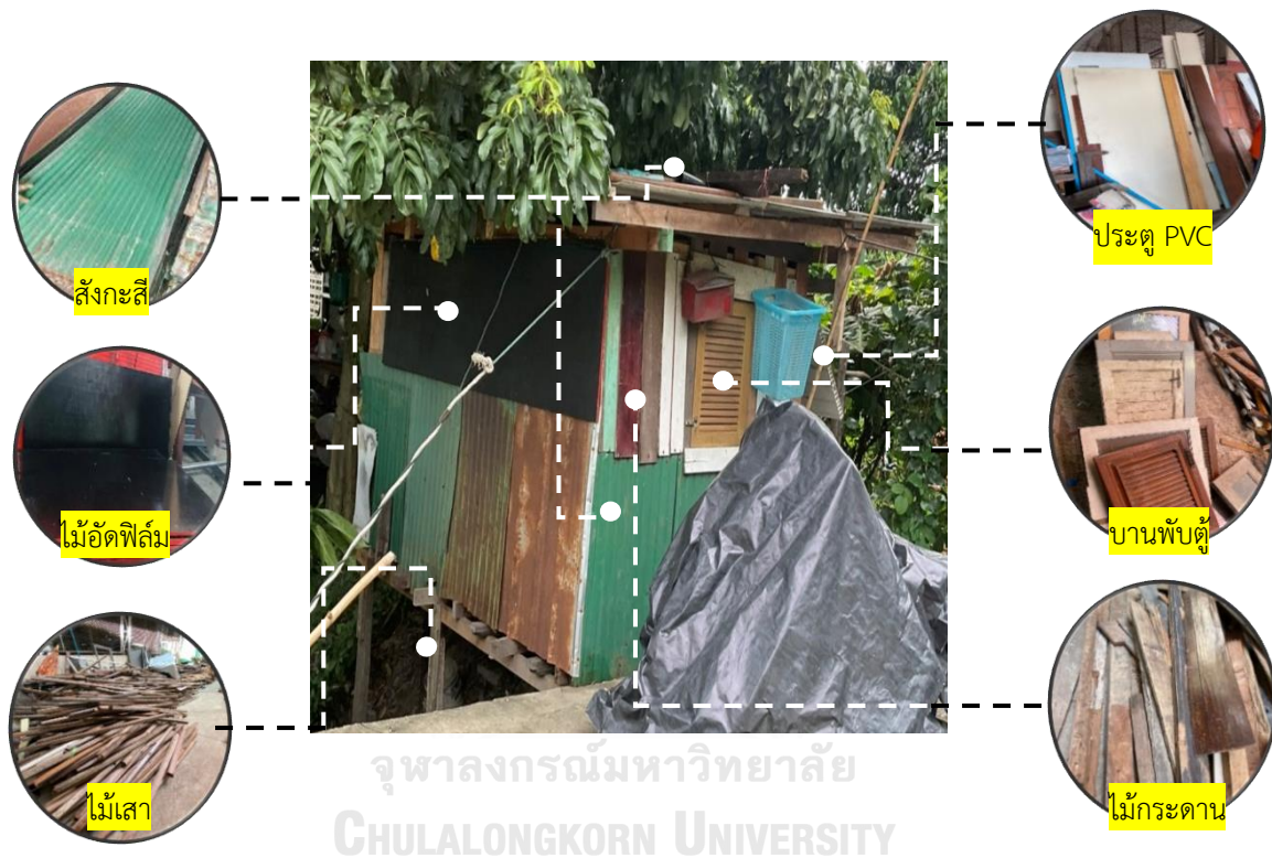
ภาพที่ 5-6 แสดงองค์ประกอบการใช้วัสดุก่อสร้างมือสองของบ้านหลังที่ 1
