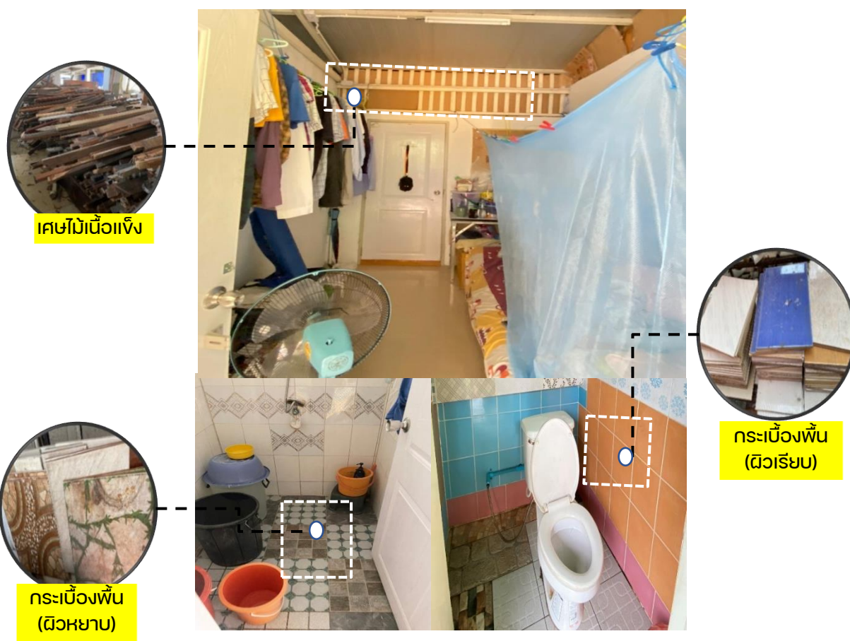
ภาพที่ 5-22 แสดงองค์ประกอบการใช้วัสดุก่อสร้างมือสองของบ้านหลังที่ 9
