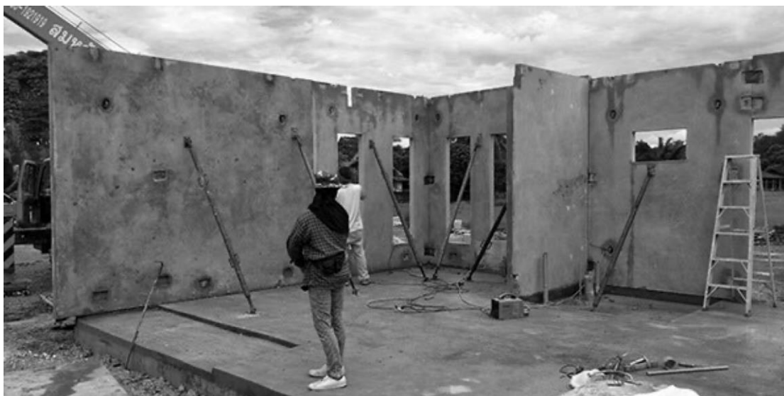
ภาพที่ 26 ชั้นส่วนแผ่นผนังรับน้ำหนัก
