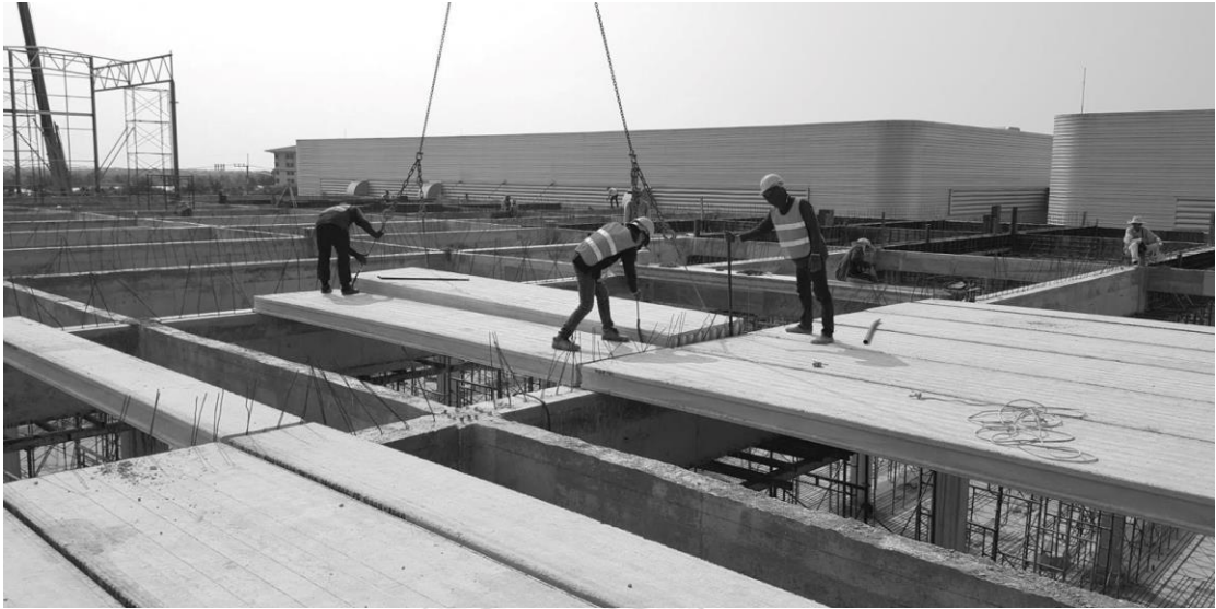
ภาพที่ 21 แผ่นพื้นคอนกรีตสำเร็จรูป
