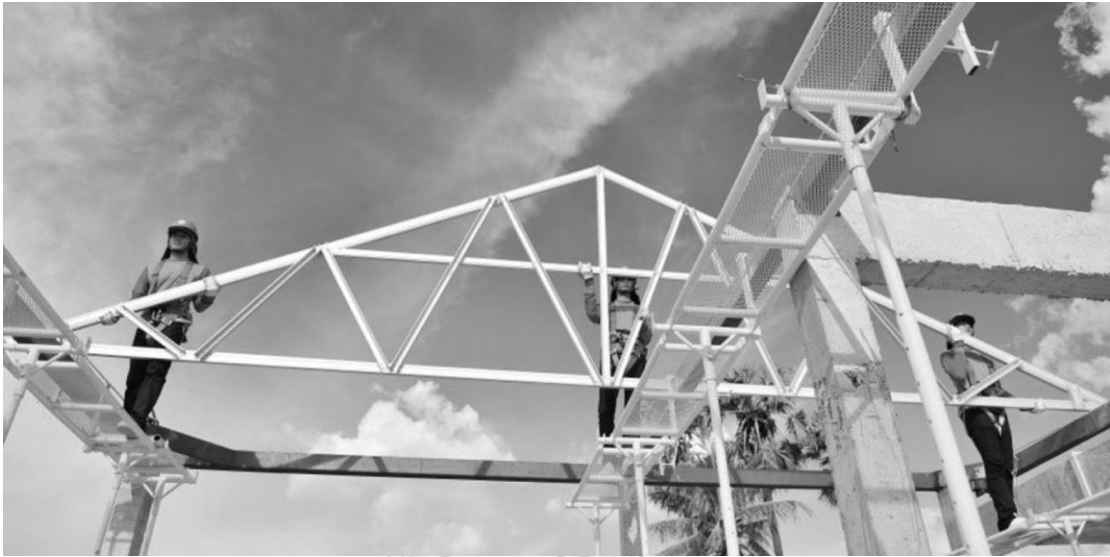
ภาพที่ 29 โครงหลังคาสำเร็จรูป
