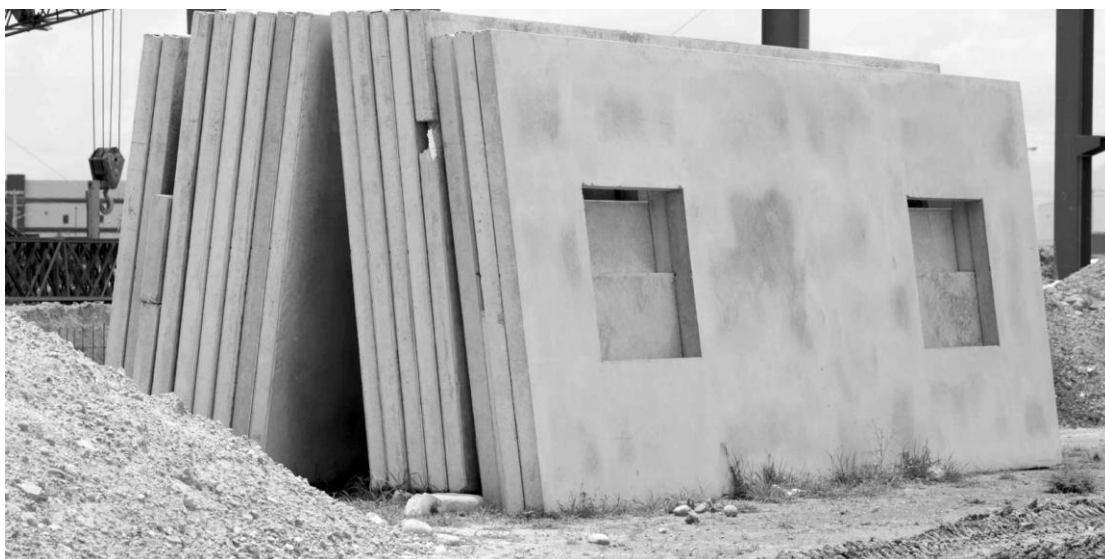
ภาพที่ 18 ชิ้นส่วนแผ่นผนังคอนกรีตสำเร็จรูป
