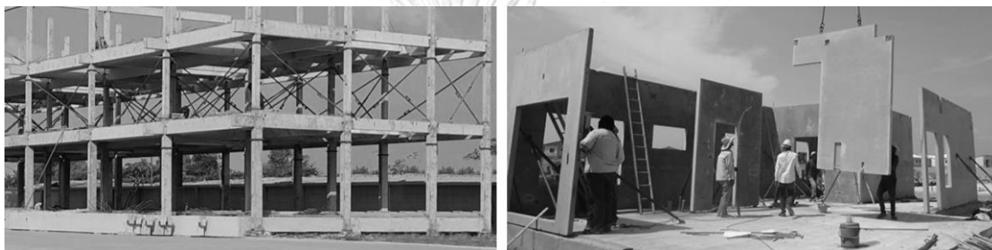
ภาพที่ 33 ระบบโครงสร้างชั้นสำเร็จรูป แบบเสา - คาน และผนังรับน้ำหนัก
