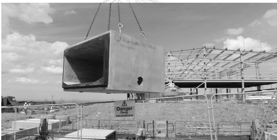
ภาพที่ 4 ระบบโครงสร้างกล่อง
