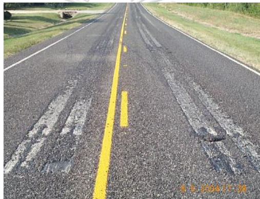
รูปที่ 16 แสดงการหลุดลอกของซีลจากการที่บรรทุกหนักใช้เส้นทาง ที่มา: TxDOT
