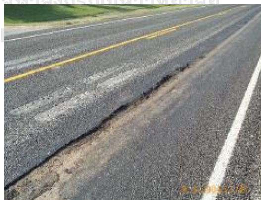
รูปที่ 17 แสดงการหลุดลอกของซีลจากการที่บรรทุกหนักใช้เส้นทาง ที่มา: TxDOT
