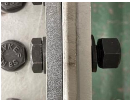
รูปที่ 2 รอยต่อที่ยังไม่ถูกตรวจสอบ
