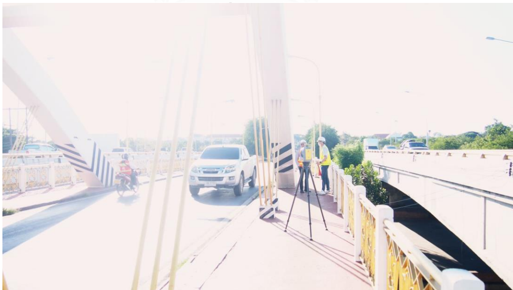
รูปที่ 3.33 3D-scan Station 5
