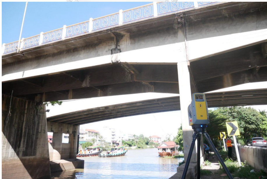
รูปที่ 3.26 3D-scan Station 1
