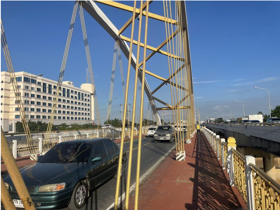
รูปที่ 3.34 3D-scan Station 9
