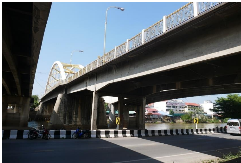
รูปที่ 3.1 ภาพด้านข้างสะพานส่วนที่มีรอยต่อเป็นคานปลายบากจากฝั่งวังน้อย
