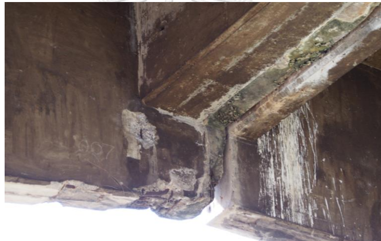
รูปที่ 3.10 รอยแตกร้าวจากการสำรวจฝั่งวังน้อย 2
