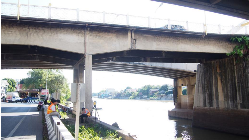
รูปที่ 3.29 3D-scan Station 4
