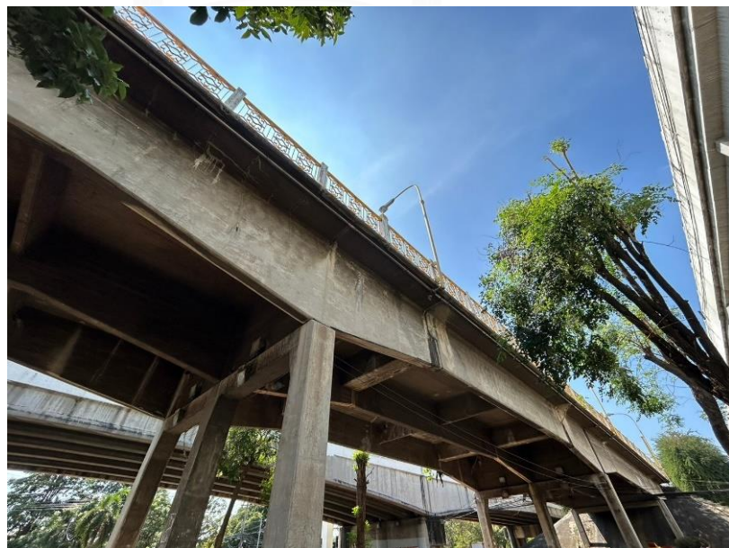
รูปที่ 3.2 ภาพด้านข้างสะพานส่วนที่มีรอยต่อเป็นคานปลายบากจากฝั่งอยุธยา
