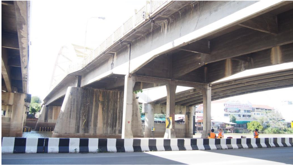
รูปที่ 3.27 3D-scan Station 2
