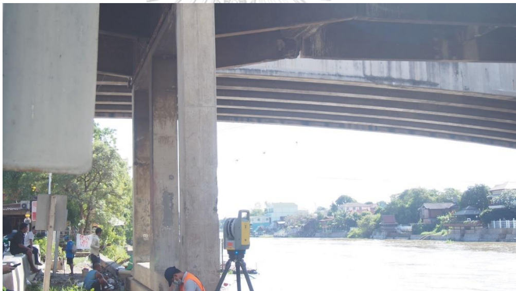
รูปที่ 3.28 3D-scan Station 3
