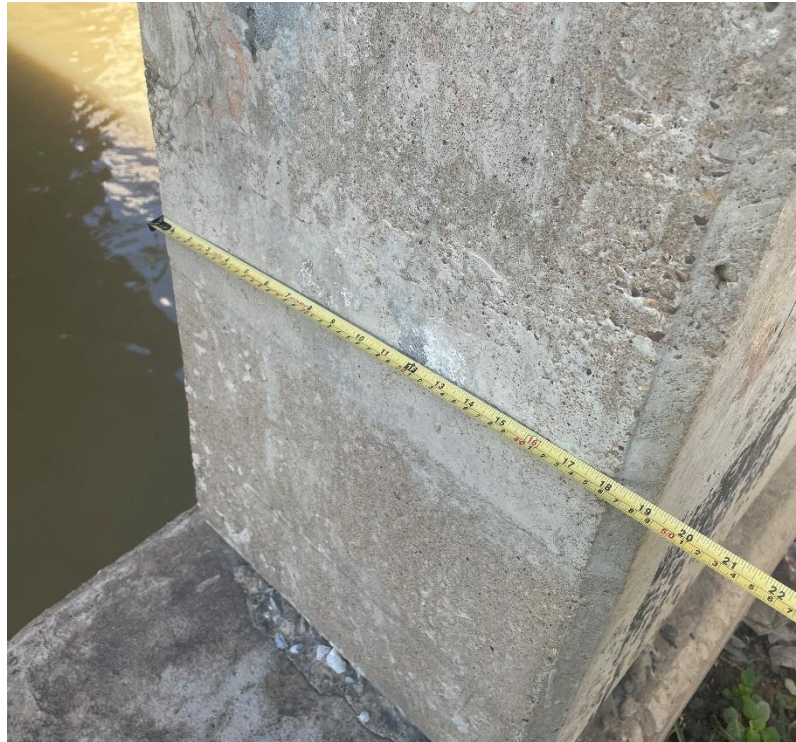
รูปที่ 3.37 ความกว้างหน้าตัดเสาวัดจากหน้างานจริง 48.7 cm
