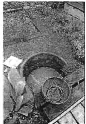
บ่อเก็บน้ำใต้ดิน ใส่วัสดุกรองน้ำรอบบ่อ ทำให้น้ำในบ่อสะอาดขึ้น
