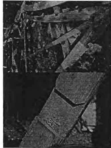
(5) การปรุงเครื่องบนโครงสร้างหลังคา
