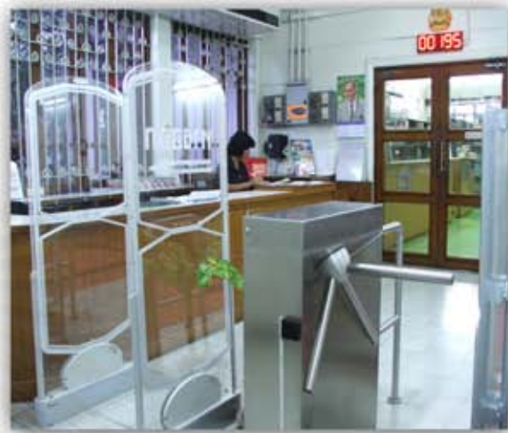
ติดตั้งเครื่องนับจำนวนผู้เข้าใช้ ระบบดิจิทัล และติดตั้งประตู ป้องกันหนังสือหาย
