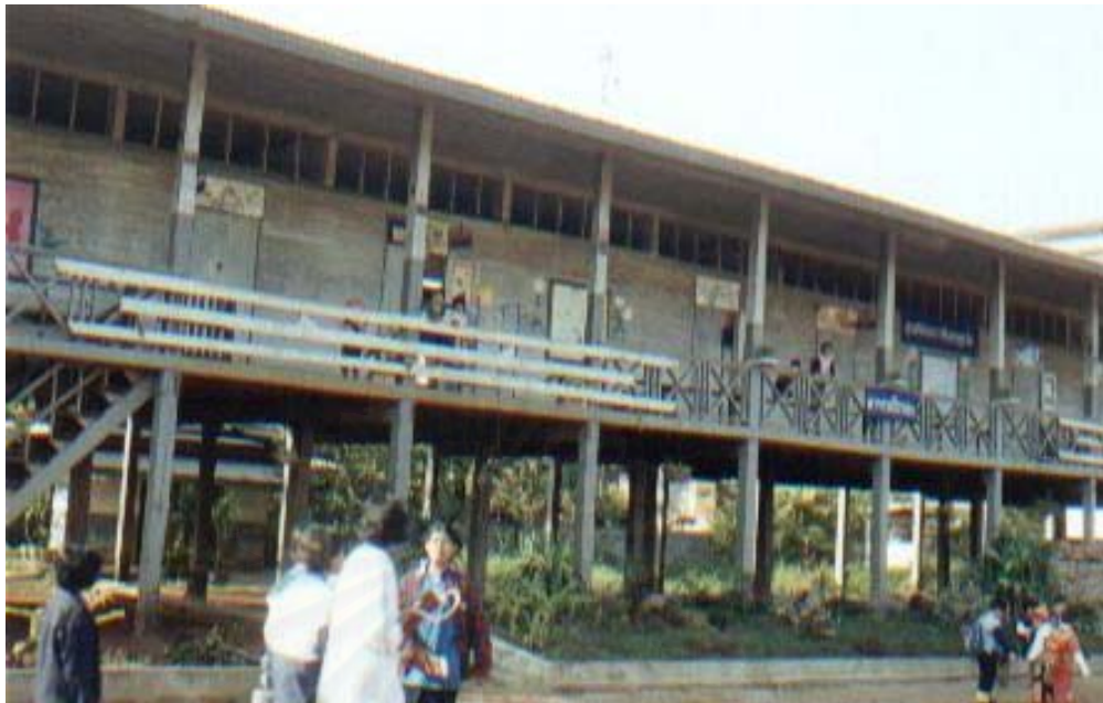
บริเวณอาคารเรียน
