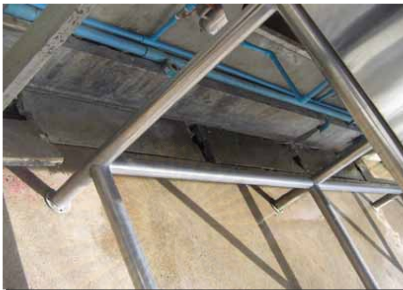
ภาพที่ 4.24 การดูแลทำความสะอาดที่ระบายน้ำเสมอ
