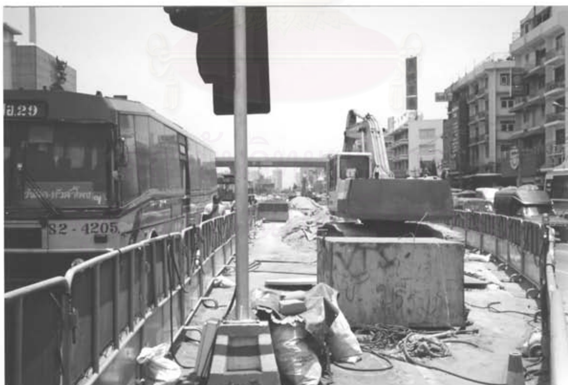
ภาพภาคผนวกที่ 4 แสดงความคืบหน้าของโครงการรถไฟฟ้าฟ้ามหานคร สถานีหัวลำโพง (ขณะเคลื่อนย้ายสาธารณูปโภคใต้ดิน)
