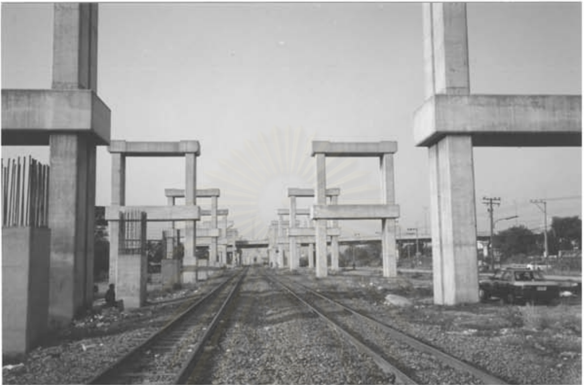
ภาพภาคผนวกที่ 5 แสดงความคืบหน้าของโครงการรถไฟฟ้าไฮปเวลล์ (บริเวณถนนกำแพงเพชร 2)
