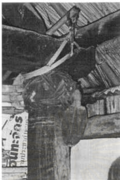
รูปที่ 57 โครงคานหัวเสาและเสาไม้ เหนื่อเสาเอก เรือนนางอ๊ด
