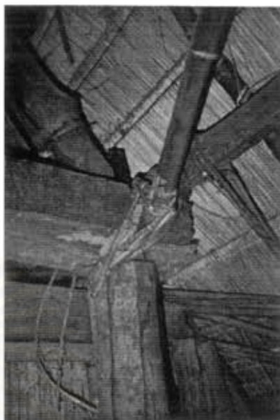
รูปที่ 49 รอยต่อของเสา ซื่อ แปหัวเสา และ ไม้ไขว้ขาเป็ย
