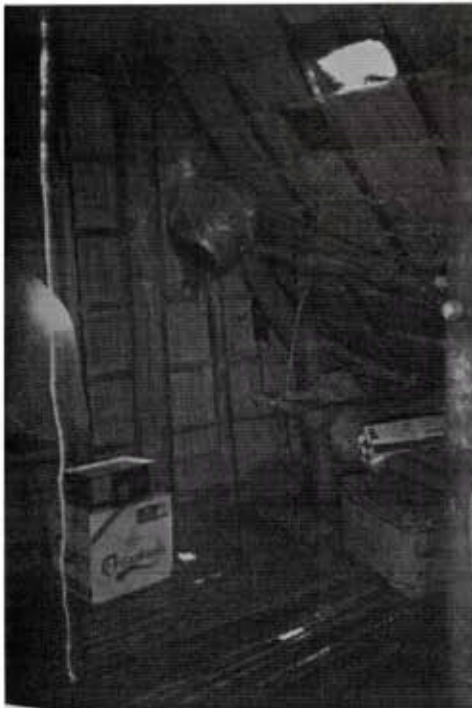
รูปที่ 43 การชักดับหลังคาหน้าคา เพื่อ ให้เป็นช่องแสงและระบายอากาศ
