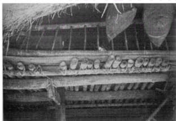
รูปที่ 51 วิธีการมัดแบบกำวาง ระหว่างตงไม้ไผ่ และ ราไม้ไผ่
