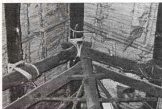
รูปที่ 59 รอยต่อของจันทัน อกไก่ และ โครงไม้รวกกันขโมย เรือนนางอ๊ด
