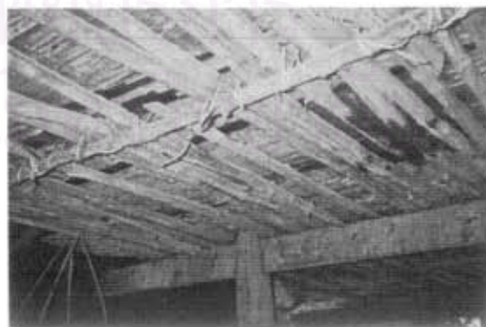
รูปที่ 61 วิธีการมัดแบบกำวางระหว่างตงไม้ไผ่ และราไม้ไผ่ เรือนนางอ๊ด
