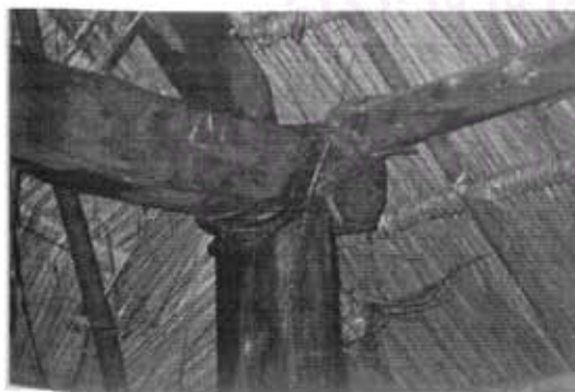
รูปที่ 60 รอยต่อระหว่างเสา ชื่อ จันทัน และแปหัวเสา เรือนนางอ๊ด
