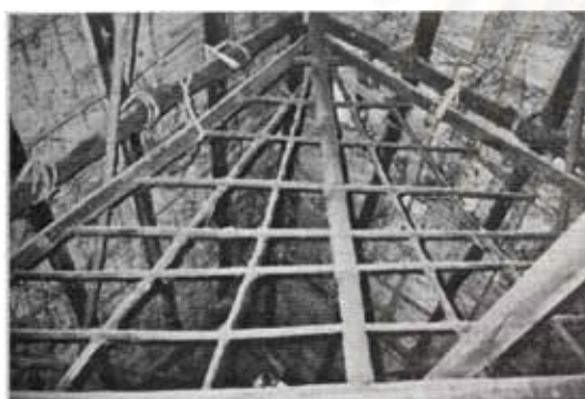
รูปที่ 58 โครงไม้รวกกันขโมย เรือนนางอ๊ด
