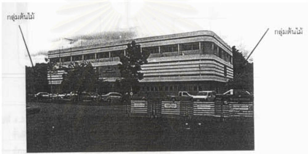
รูปที่ 4.1 ภาพอาคารกองวิทยากร กรมช่างโยธาทหารอากาศ พิจารณาจากภายนอกอาคารด้านทิศใต้
